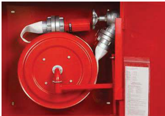
Εικόνα 1 - Π.Φ. με εύκαμπτο (επίπεδο) πυροσβεστικό σωλήνα κατά ΕΛΟΤ EN 671-2
