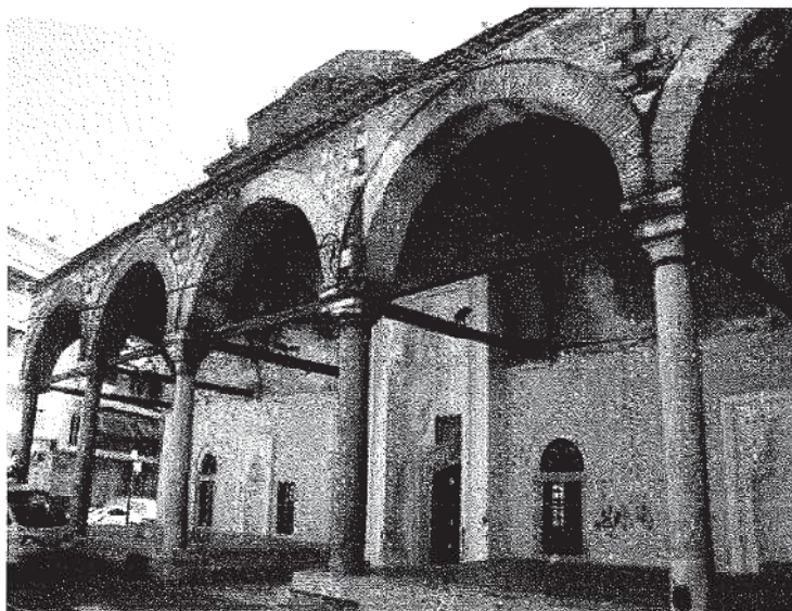
Σχήμα Π.20: Ξύλινοι ή μεταλλικοί ελκυστήρες σε τόξα, καμάρες και τρούλους βυζαντινών και οθωμανικών μνημείων
