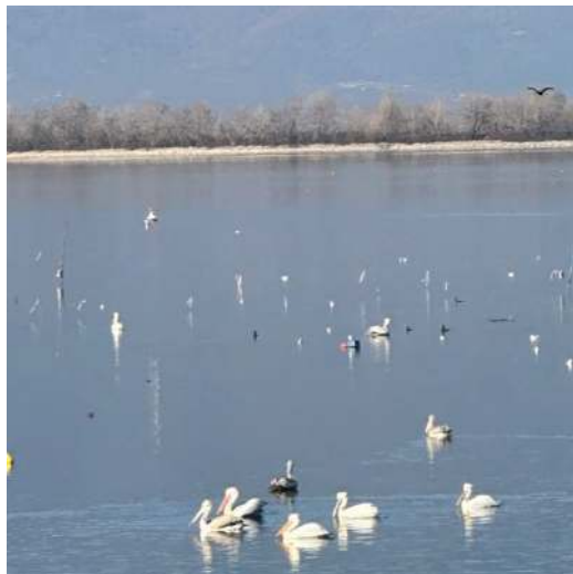
Εικόνα 3-16: Ανατολικά αναχώματα της λίμνης Κερκίνης.
