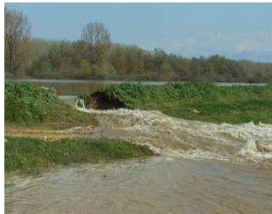
Εικόνα 3-17: Σπασμένο ανάχωμα στην περιοχή του Πεθελινού 29/03/2015.
