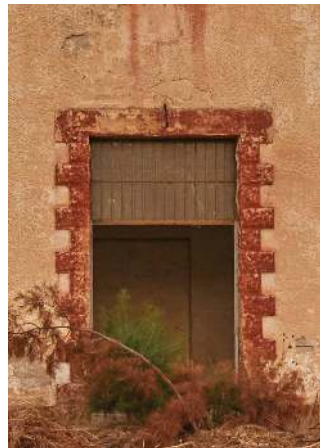
Πλαίσιο θύρας με ασβεστοτσιμεντοκονίαμα σε απομίμηση πέτρας
