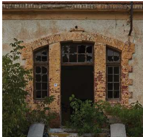
Τοξωτό πλαίσιο θύρας με συνδυασμό από ασβεστοτσιμεντοκονίαμα σε απομίμηση πέτρας και τουβλάκι
