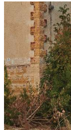
Διαμόρφωση βάσης των κτιρίων με ασβεστοτσιμεντοκονίαμα σε απομίμηση πέτρας
