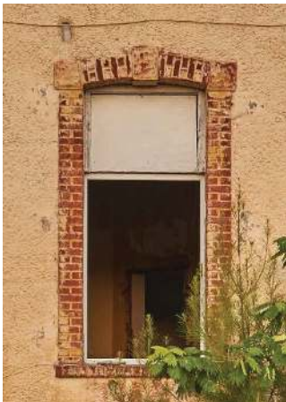
Περιμετρικό πλαίσιο παραθύρων με τουβλάκι και τοξωτό υπέρθυρο
