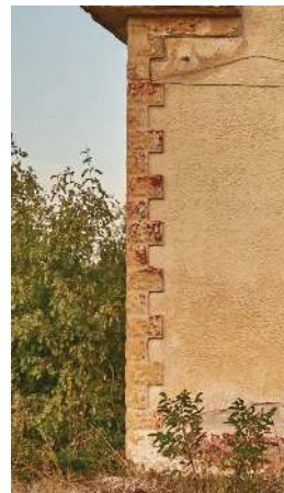
Διαμόρφωση γωνιών των κτιρίων με ασβεστοτσιμεντοκονίαμα σε απομίμηση πέτρας
