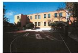
Άποψη υφιστάμενου κτιρίου
