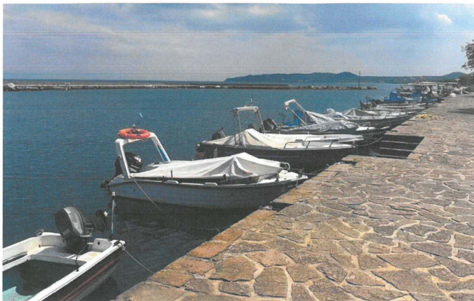
Εικόνα 1: Υφιστάμενη λιμενική υποδομή αλιευτικού καταφυγίου Θερμής (ΝΑ τμήμα λιμένα)
