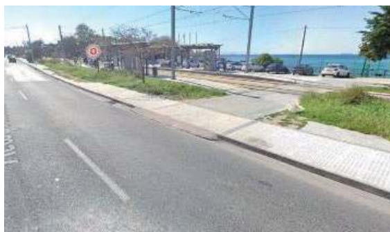
Εικόνα 2.14 : είσοδος οχημάτων, σε χώρο στάθμευσης νότια των γραμμών του Τραμ
