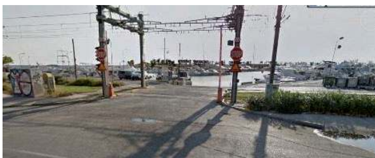
Εικόνα 2.19: Θέση Χ.Θ. 12+760, είσοδος οχημάτων
