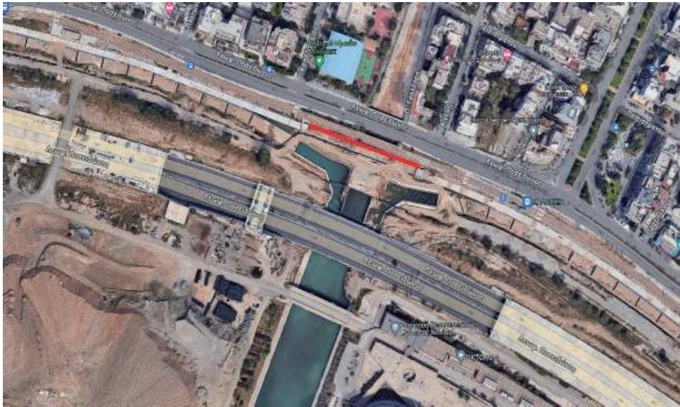
Εικόνα 2.2: Τμήμα διέλευσης ποδηλατοδρόμου επί των εκβολών Ιλισού
