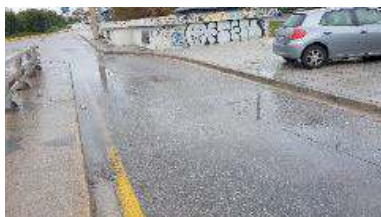
Φωτογραφία 2.15 : Τμήμα οδού με περιορισμένα γεωμετρικά στοιχεία
